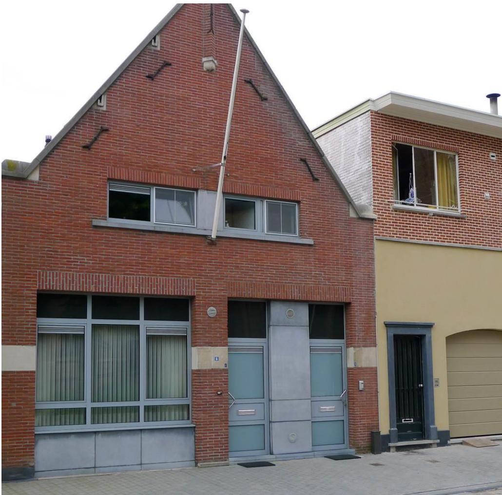
De vroegere waag, gebouwd in 1938 (foto 2011).
