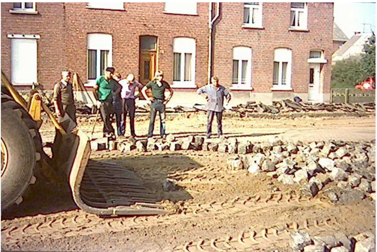
De kasseien van die wegen werden in 1974 opgebroken en de straten gasfteerd (Foto Frans Cuyvers, tegenover zijn Bazarke).
