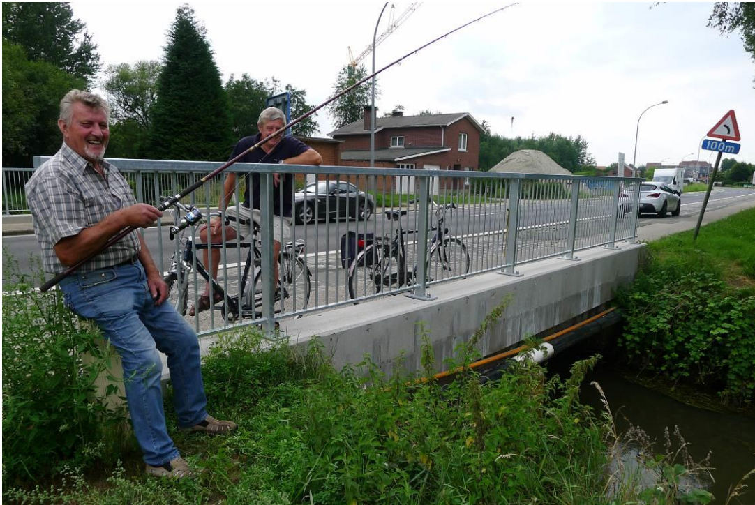
De brug van de Borgerhoutsendijk (B1) met Jan Caers als de loze visser en nog met de onlangs afgebroken portierswoning van het zuiveringsstation.
