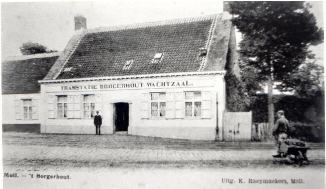
TRAMSTATIE BORGERHOUT WACHTZAAL , nu tegenover benzinstation Texaco
